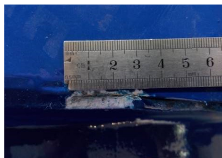
b 焊缝裂纹
