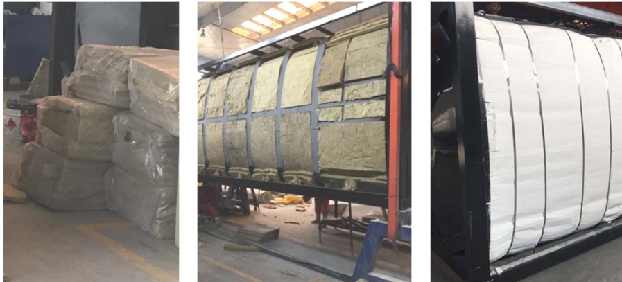
a 待裁剪岩棉板 b 一层岩棉铺装 c 二层特殊胶体铺装
