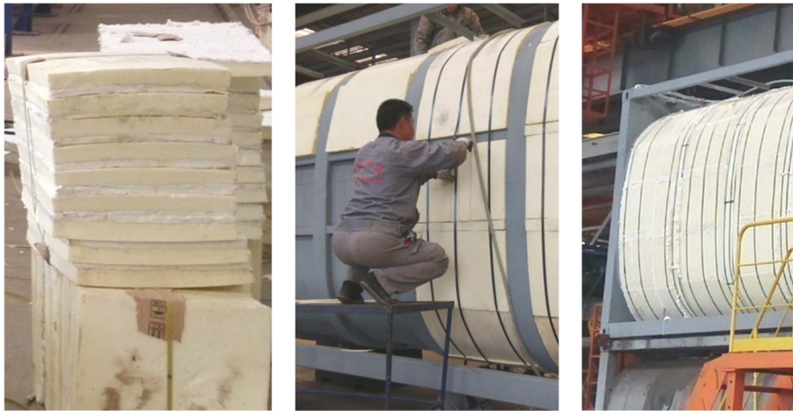
a 单块复合聚氨酯网块 b 复合聚氨酯积木式拼装 c 复合聚氨酯网块间的发泡
