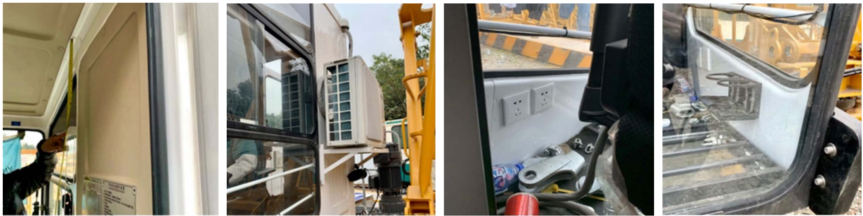
图 6 塔机驾驶室生活区细节 Fig.6 Details of tower crane cab living area
