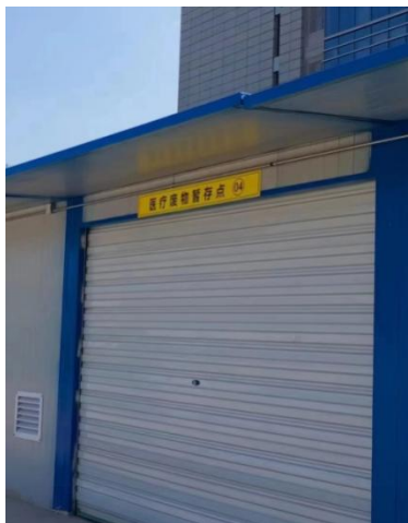
图7 医疗废物暂存点
