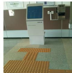
图3 导向系统处的盲道设计
