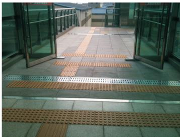
图1 韩国某地铁入口盲道设计
