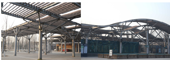
图 5 室外钢结构 Fig.5 Exterior steel structure
